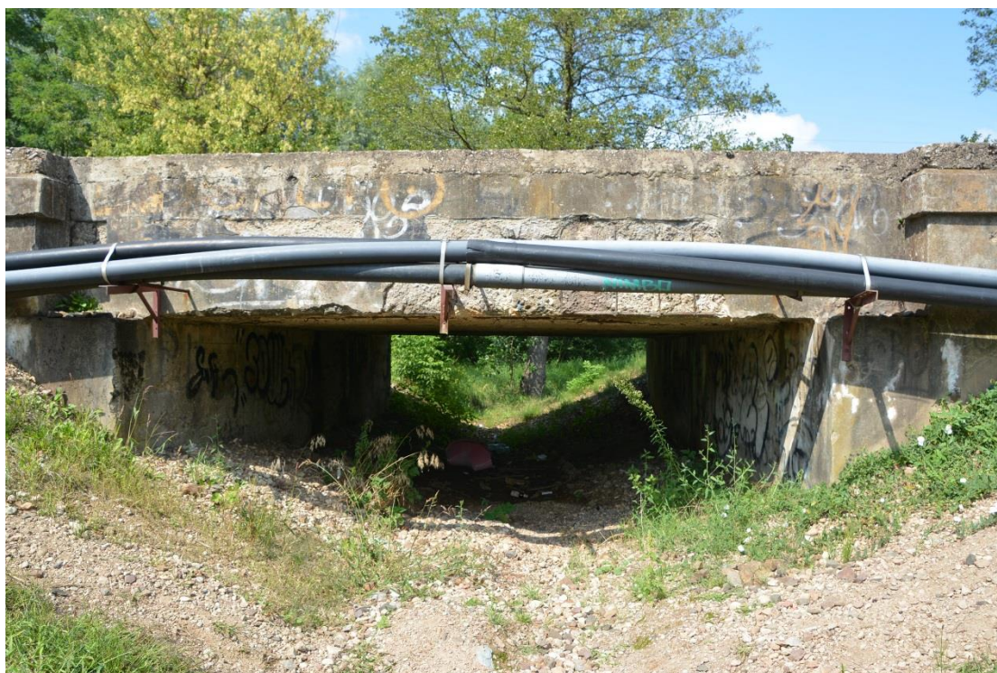
Fot. 2. Widok mostu z boku od strony toru nr 2
