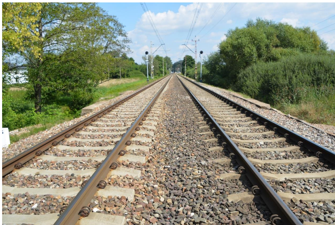
Fot. 3. Widok nawierzchni kolejowej na moście i dojazdach
