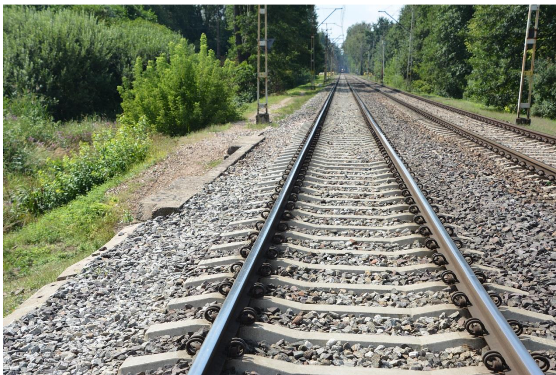
Fot.6. Widok nawierzchni kolejowej na moście tor nr 2
