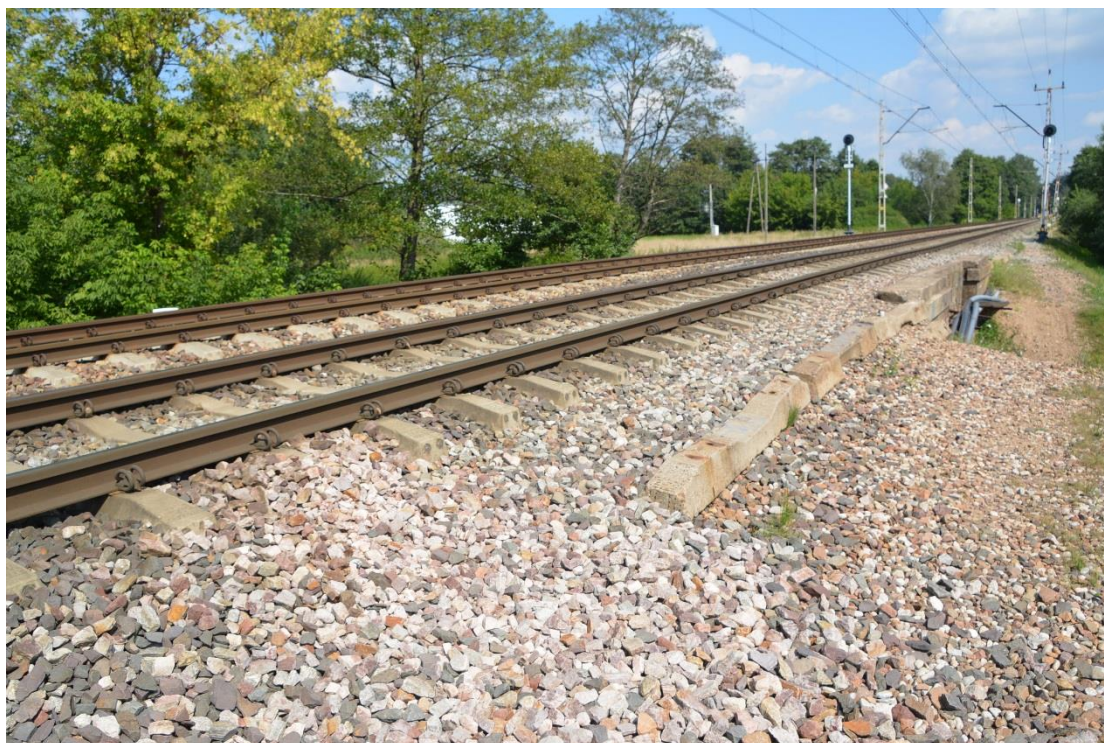
Fot. 5. Widok nawierzchni kolejowej na moście tor nr 1
