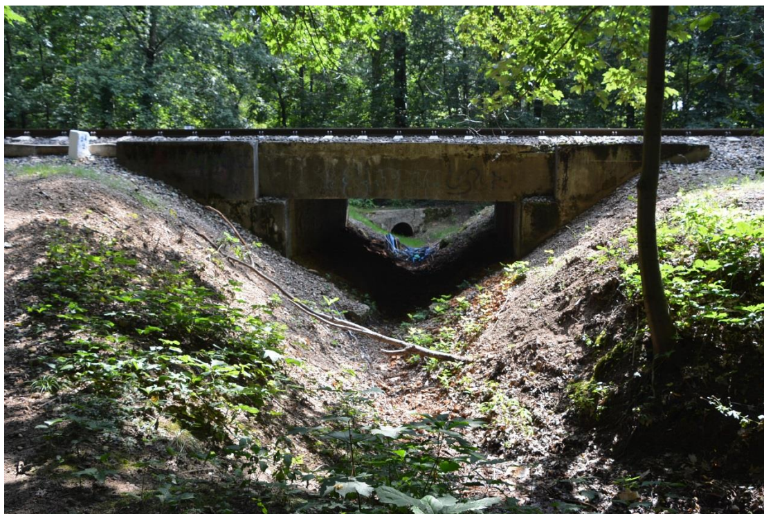
Fot. 1. Widok mostu z boku od strony toru nr 1
