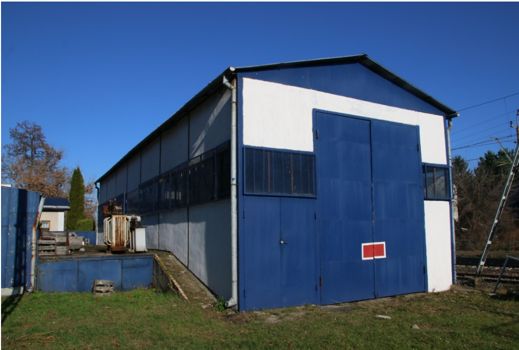
Hangar pociągu sieciowego
